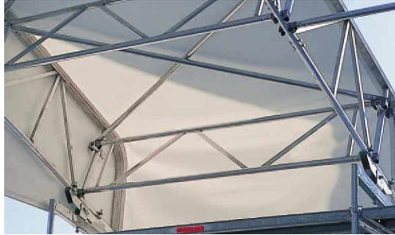
Nur in jedem fünften Feld sind Windverbände nötig – **Aluminium** für die Bauteile reduziert das Gewicht und beschleunigt dadurch die Montage; Einrastklauen als schnelle Verbindungselemente fallen in die Halterung und sitzen fest. (Spannweiten bis 15,6m gemäß Abbildung).
