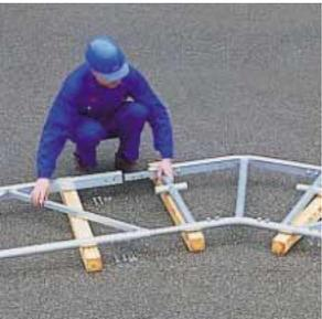
▲ Schnelle Montage der Binderelemente dank Steckverbindungen am Boden; Sicherung der Stöße mit Bolzen.
